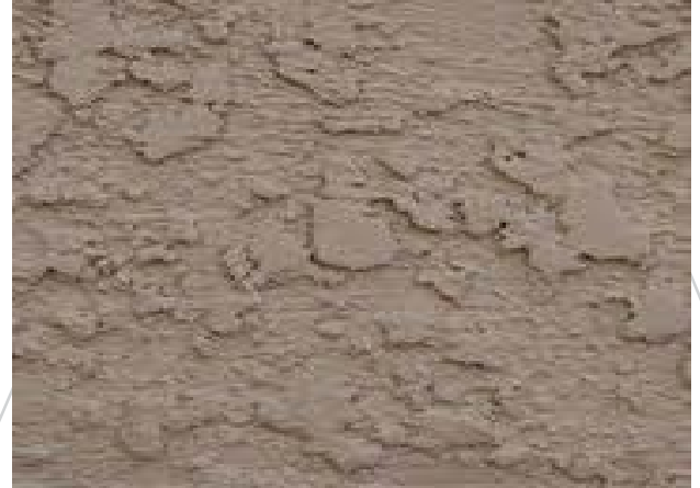
Figura 6: Ejemplo de superficie con llana
