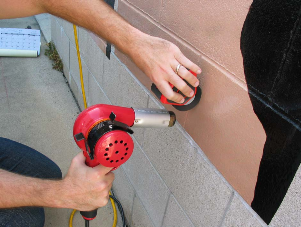
Figura 1: Instalando una lechada verticalmente
